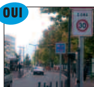
2• Un aménagement plus complexe, avec une nette différenciation visuelle de la zone 30 (couleur de revêtement différente, arasement des bordures de trottoirs, passages piétons fréquents, création de courbes...) : aménagement coûteux mais nécessaire pour amener les voitures à changer de vitesse dans les rues à trafic élevé ou servant au transit.
