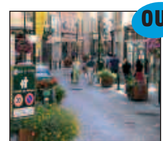
3• La zone 30 avec priorité piéton sur toute la longueur, avec arasement des bordures de trottoirs, suppression des passages piétons : adapté dans les rues commerçantes étroites, avec une forte fréquentation piétonne où les voitures sont amenées à faire des arrêts fréquents et à rouler au pas.
