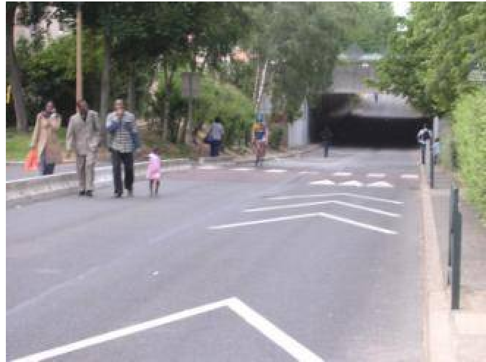
Voie de bus de 7-8 m de large en site propre à Evry avec trottoirs de 70-80 cm
