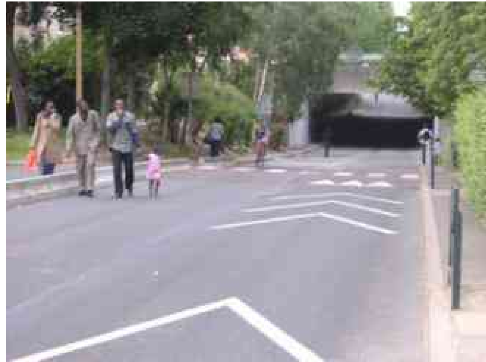
Voie de bus en site propre à Evry
